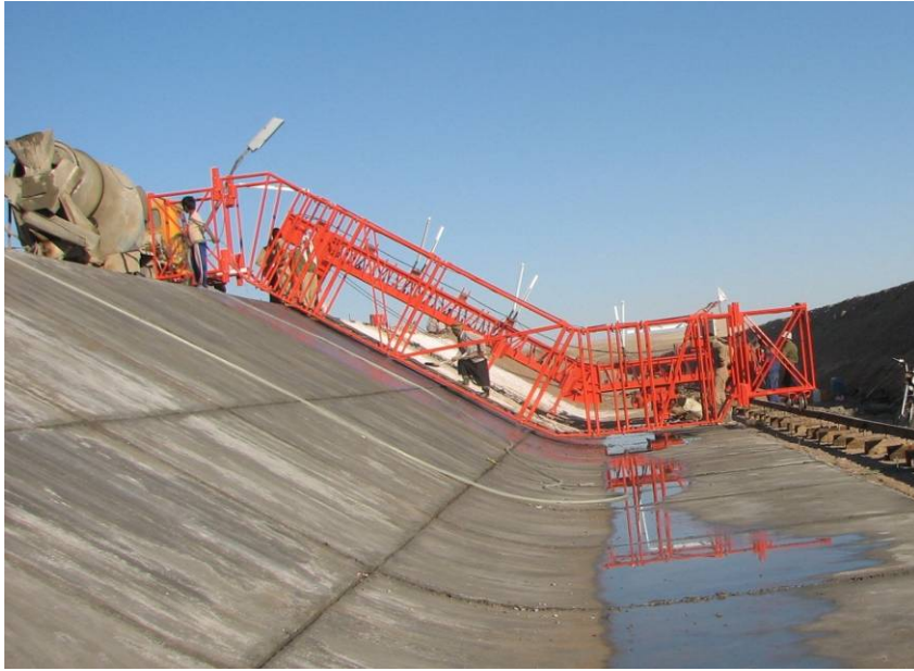
شکل (۲): نمونه دستگاه لاینر جهت اجرای بتن پوششی کانال (لاینینگ)
